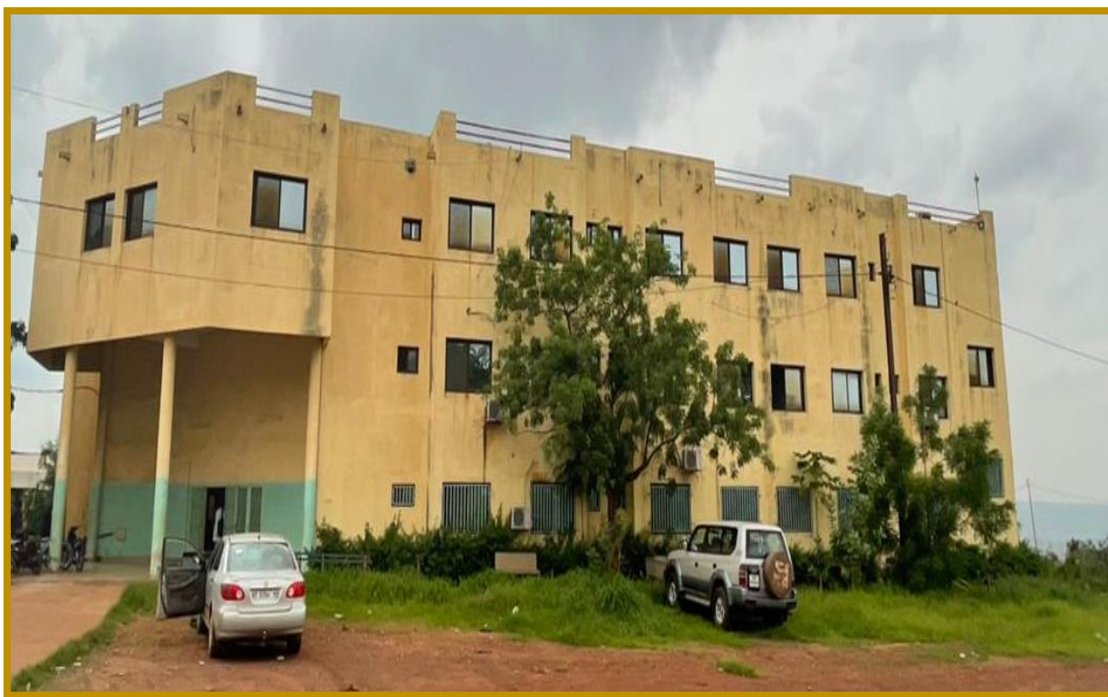
Figure 6 : Vue d'ensemble de face convexe – Médecine Interne côté sud au bord de la route
