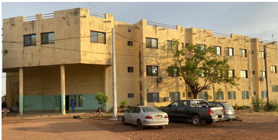
Figure 21 : Vue d'ensemble de face convexe _ Médecine Interne côté sud au bord de la route
