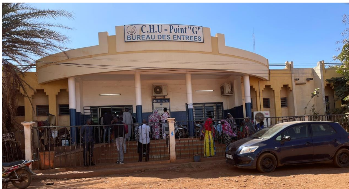
Figure 20 : Bureau des entrées du CHU du Point G
