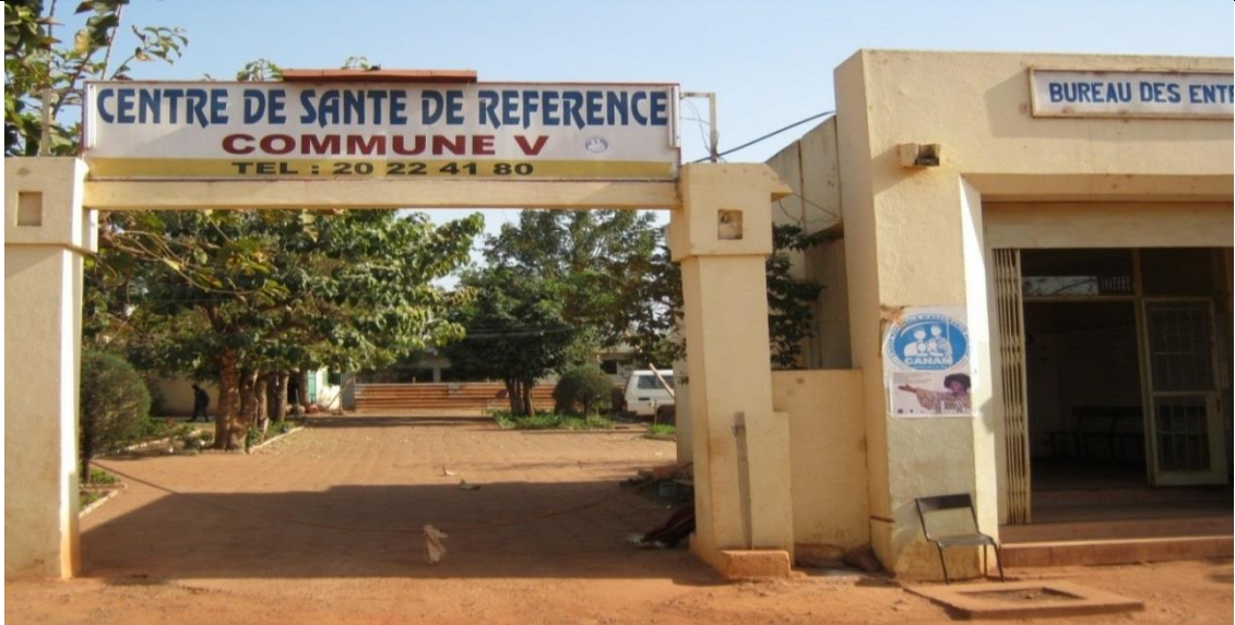
Figure 1: Vue de la façade principale du centre de santé de référence de la commune V du District de Bamako
