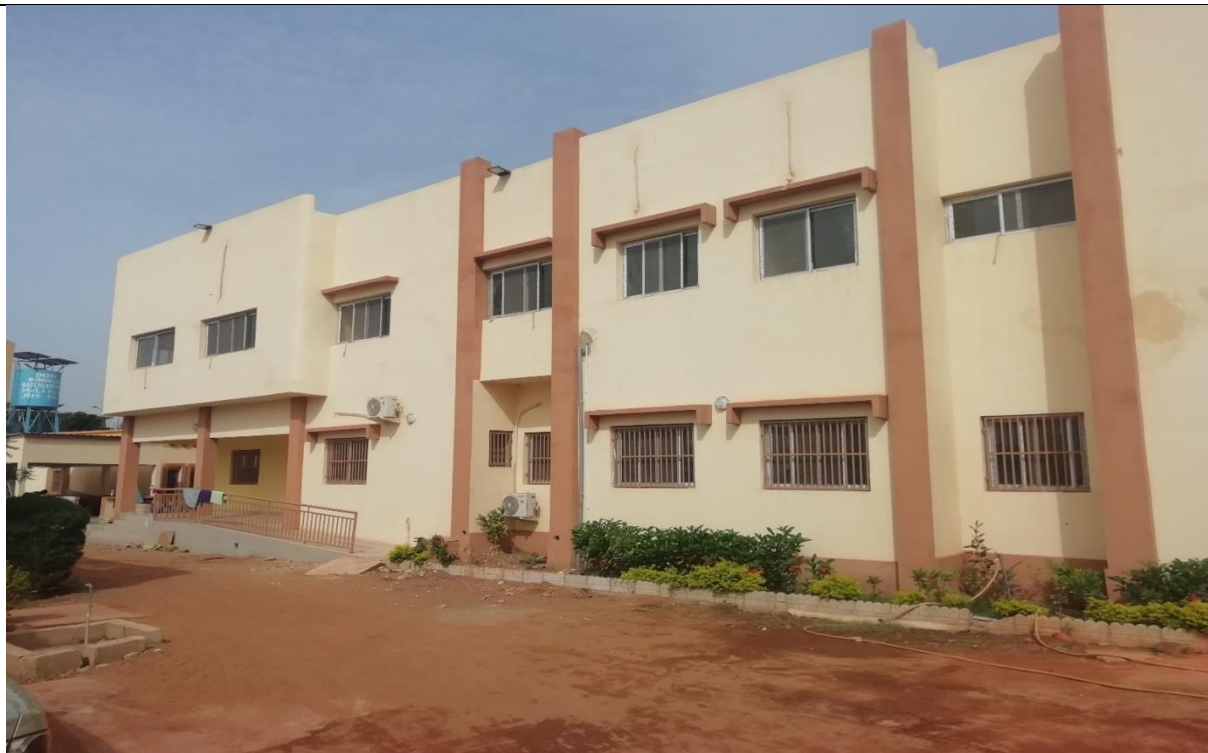
Figure 2: Vue de la façade principale du service de pédiatrie.
