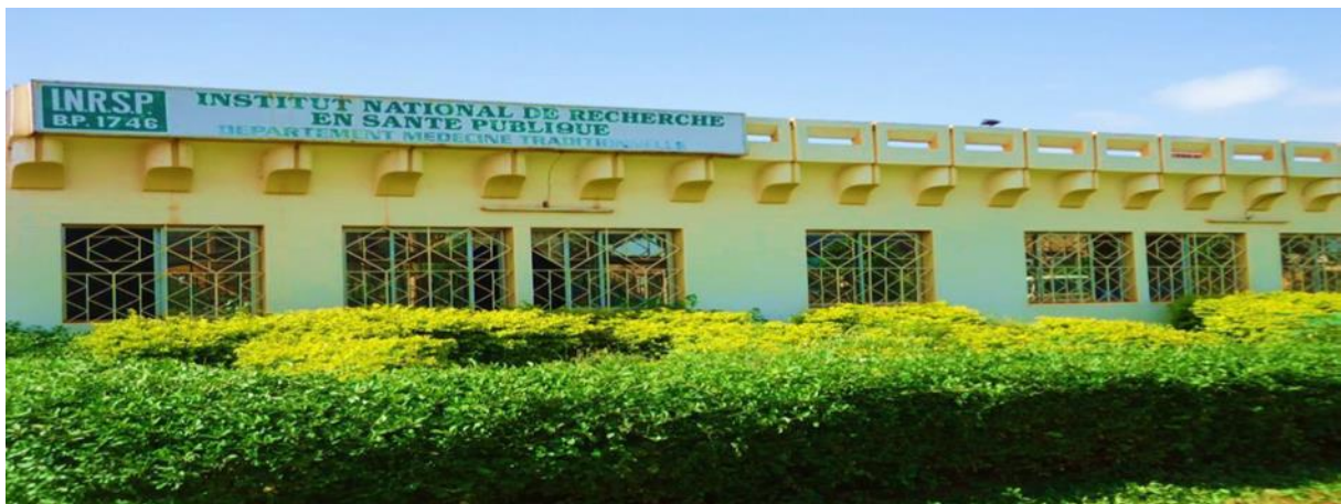
Figure 12: Lieu d'étude photo du DMT (Vue de face du bâtiment).
