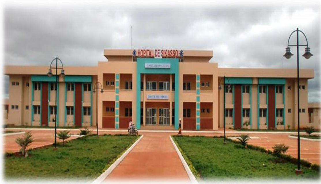
Figure 23 : Hôpital de Sikasso.
