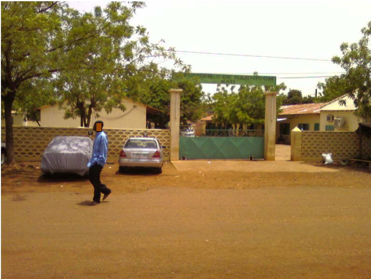
Fig.16 Vue photographique de l'entrée principale de l'Infirmierie de Garnison de Kati.
