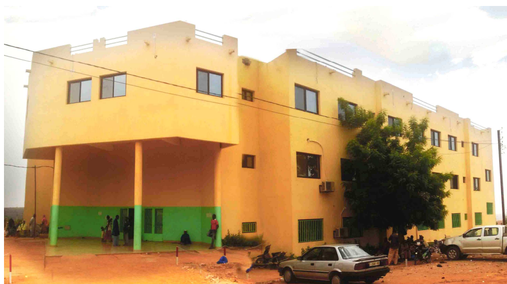
Photo 7 : Entrée principale – Médecine Interne côté sud au bord de la route
