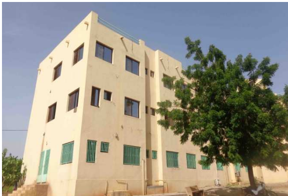
Photo 9 : Flanc Est du bâtiment – Médecine Interne côté Psychiatrie avec une des portes secondaires
