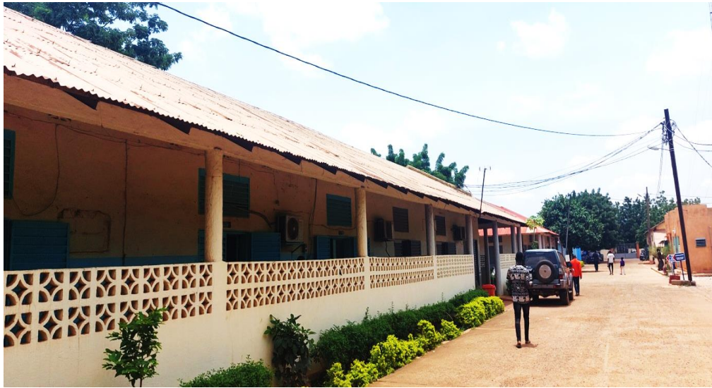
Fig. 14 : Image du bâtiment d'Imagerie du CMCAB
