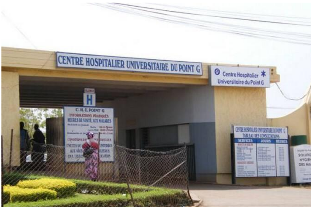
Figure 10: Image du CHU du Point G (entrée principale).
