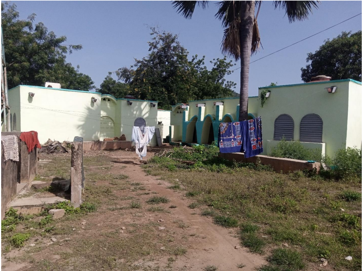
Figure 1 : ancien bâtiment du CSCOM de SEBEKORO
