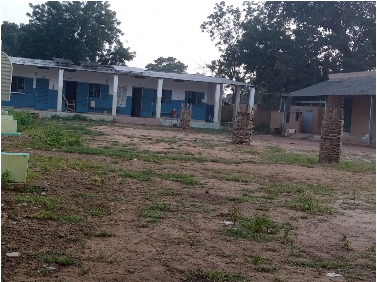
Figure 2 : nouveau bâtiment du CSCOM de SEBEKORO
