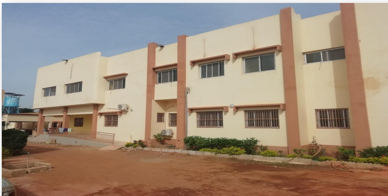
Figure 4 : Vue photographique du service de pédiatrie
