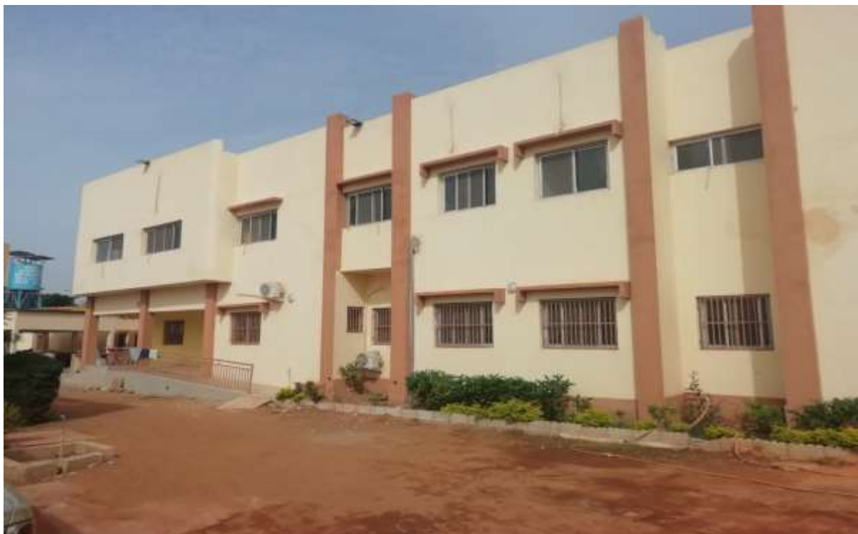
Fig.5 : Vue photographique de la façade principale du service de pédiatrie.
