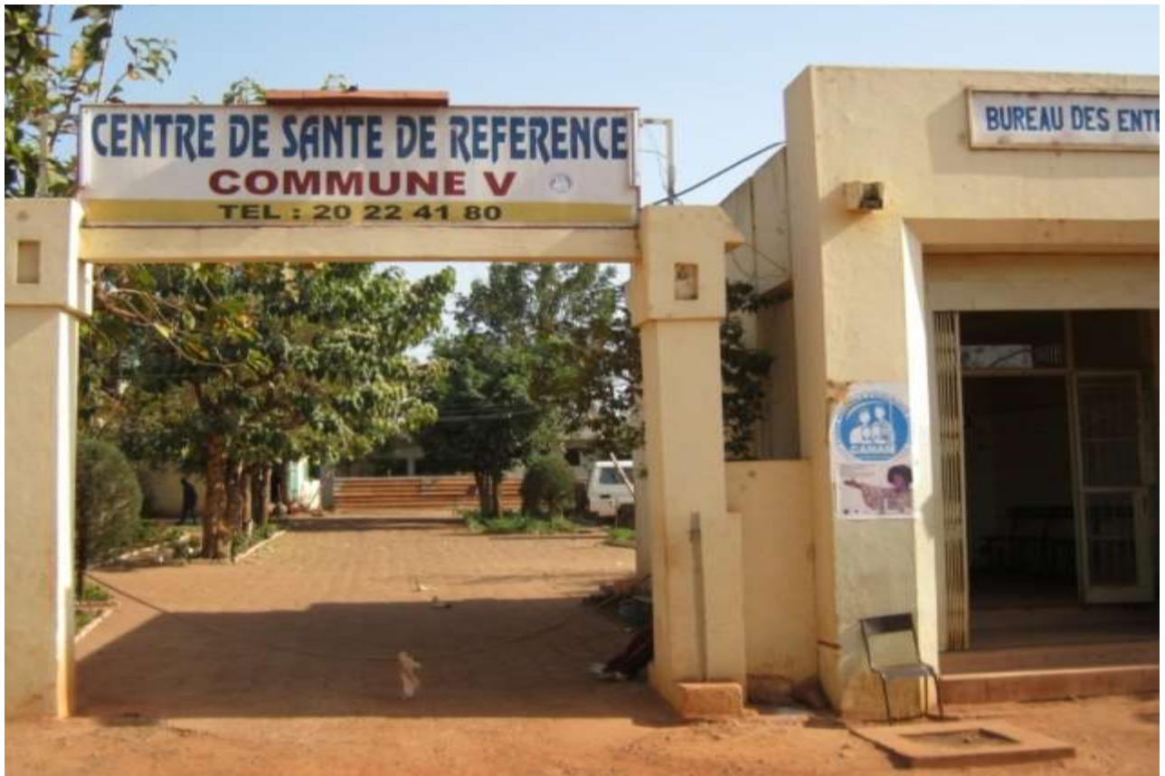
Fig.1 : vue photographique de l'entrée principale du Centre de Santé de Référence de la Commune V du district de Bamako.
