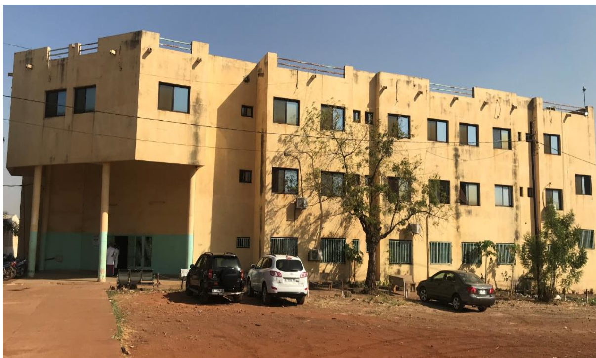
Figure 5 : Vue d'ensemble de face convexe – Médecine Interne côté sud au bord de la route.
