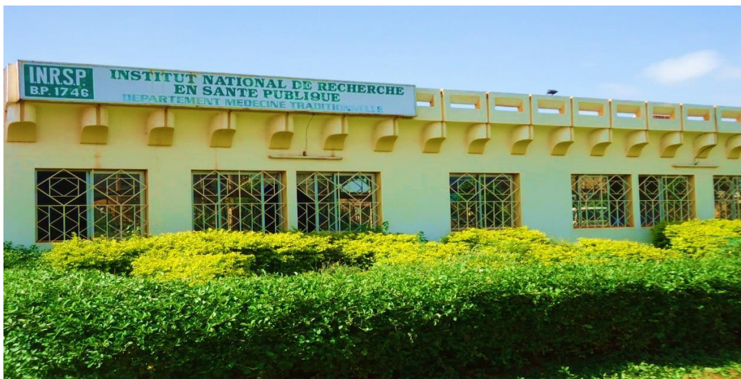
Figure 1: Photo d'une des façades du DMT
