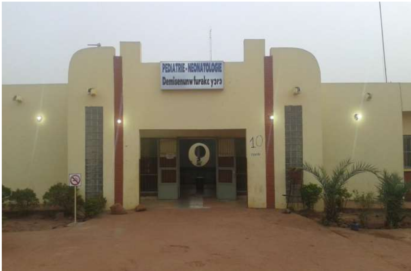
Figure 2: vue photographique du service de pédiatrie
