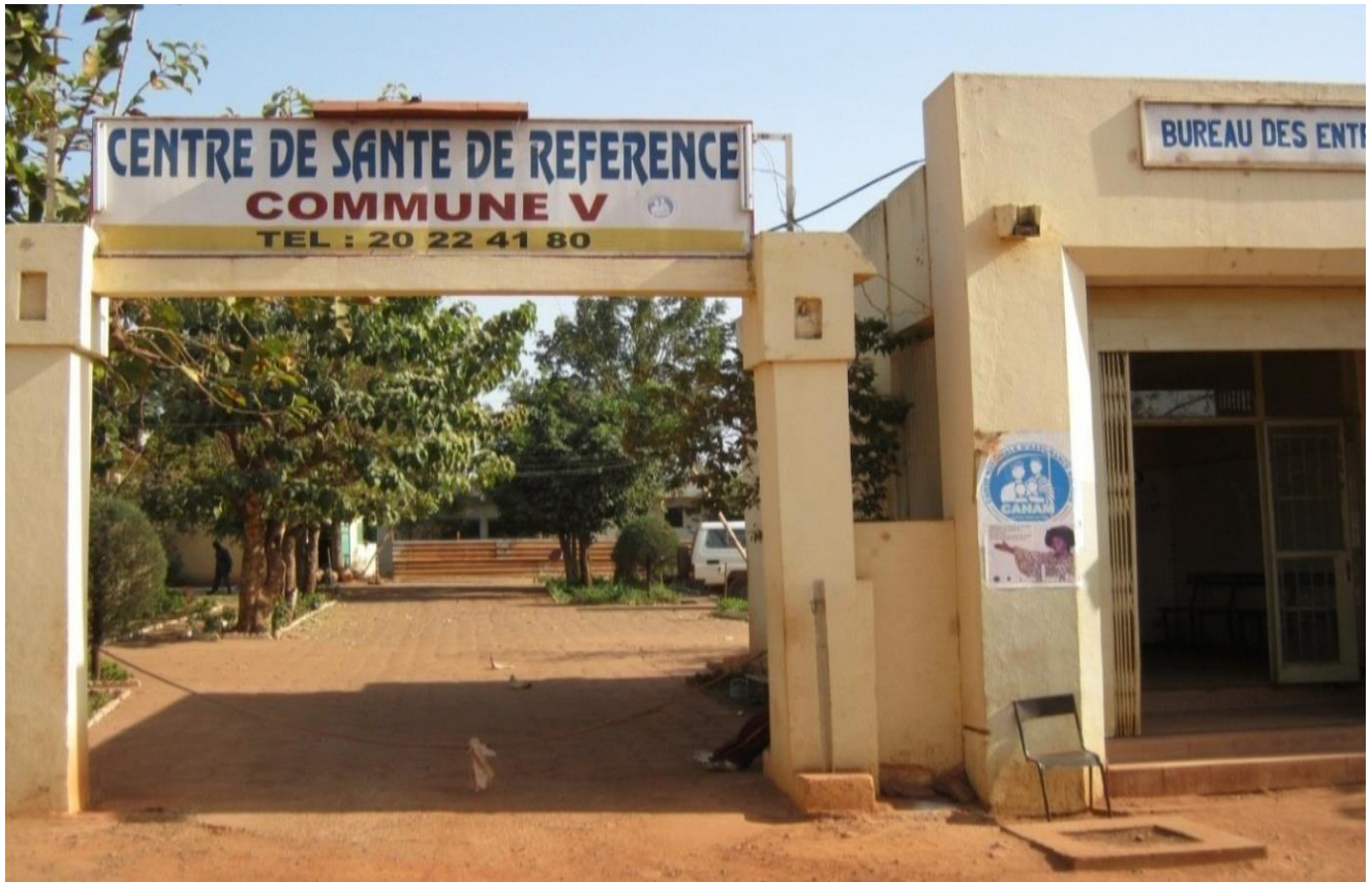
Figure 3 : Vue photographique de l'entrée principale du Centre de Santé de Référence de la commune CV du district de Bamako.
