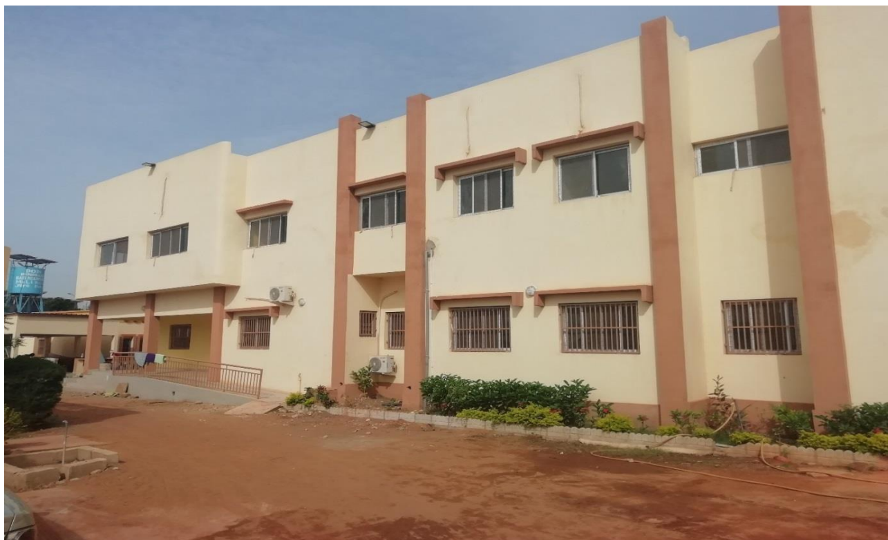
Figure 4: Vue photographique de la façade principale du service de pédiatrie.
