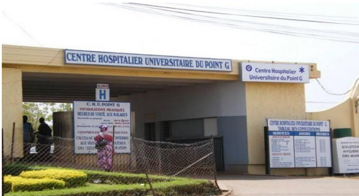
Figure 8:Entrée du CHU-Point G
