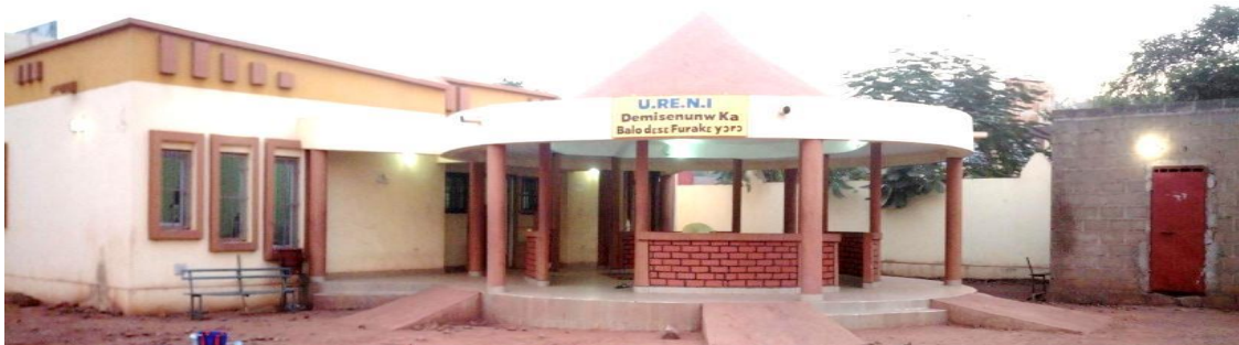
Figure 3 : Vue Photographique de la façade principale de l'URENI
