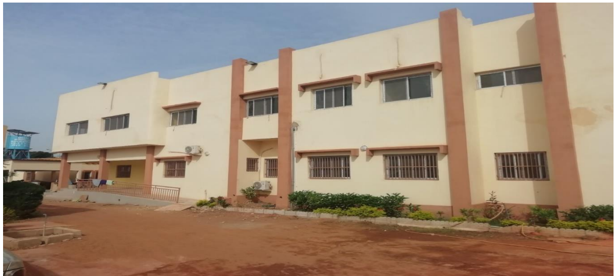
Figure 4 : Vue photographique de la façade principale du service de pédiatrie
