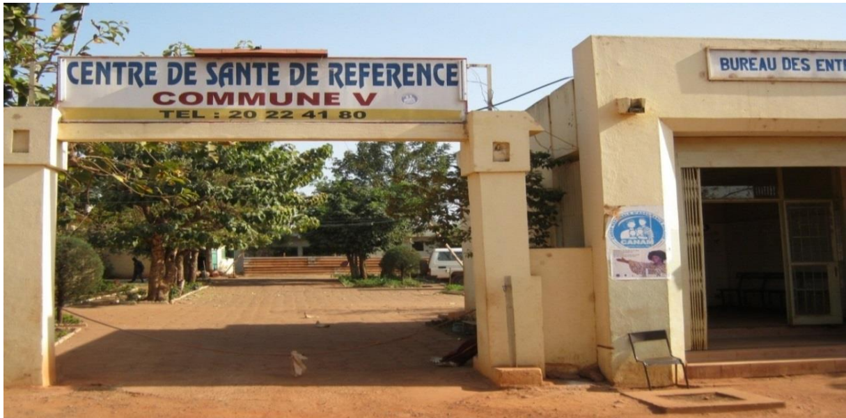
Figure 3: Vue photographique de la façade principale du centre de santé de référence de la commune V du district de Bamako
