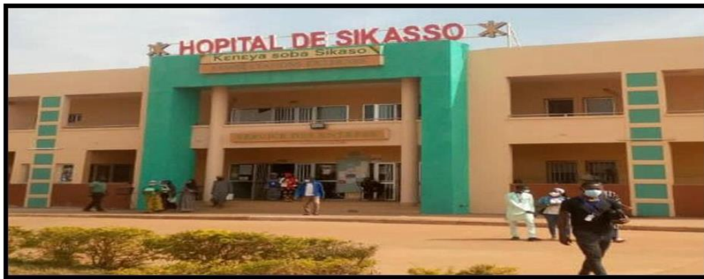
Figure 3: Hôpital de Sikasso
