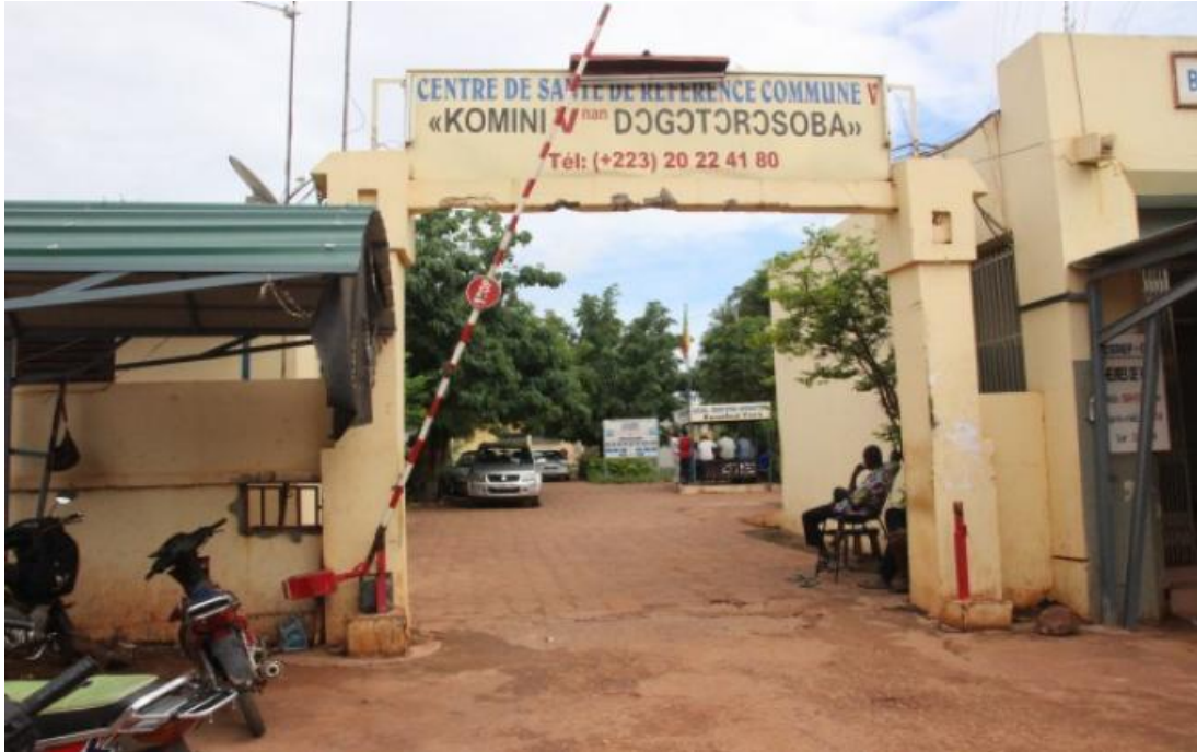
Figure 1 : vue photographique de l'entrée principale du Centre de Santé de Référence de la Commune V du District de Bamako.
