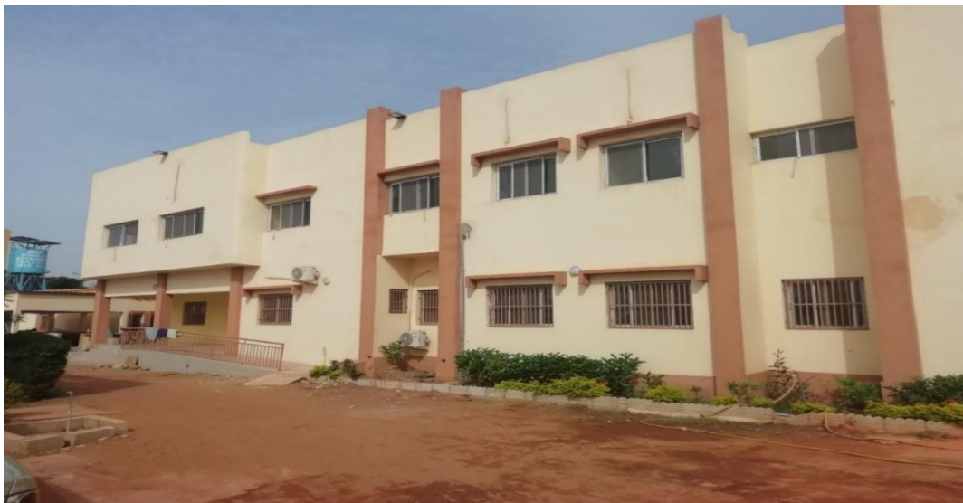
Photo 3 : Vue photographique de la façade principale du service de pédiatrie
