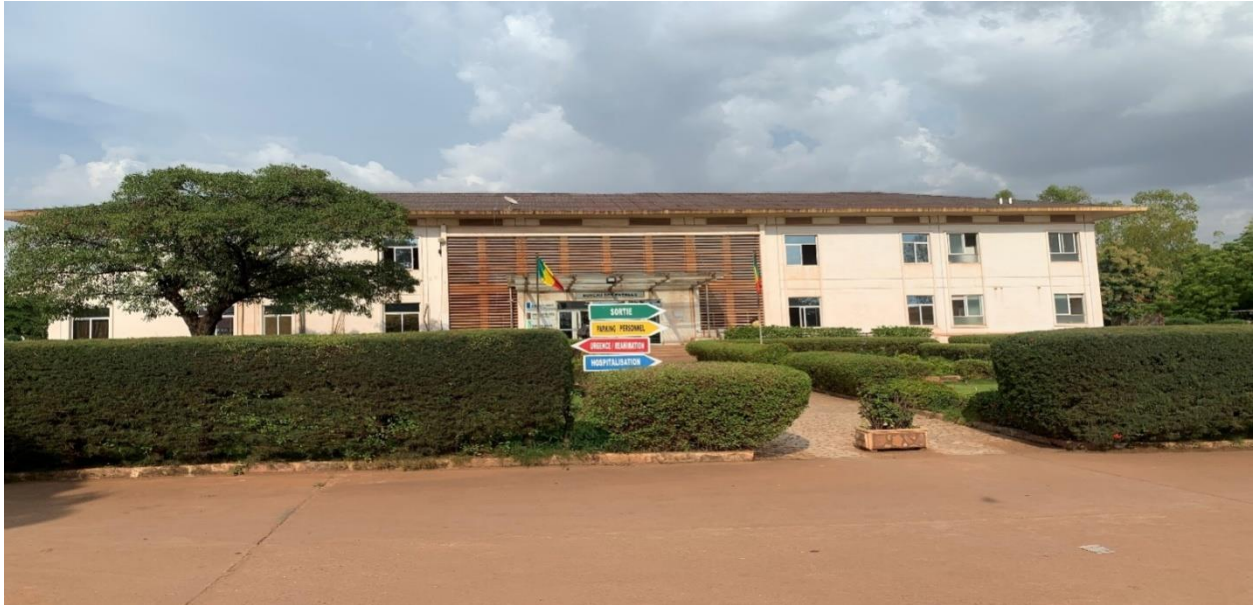
Figure 30 : vu de face de l'hôpital du Mali.
