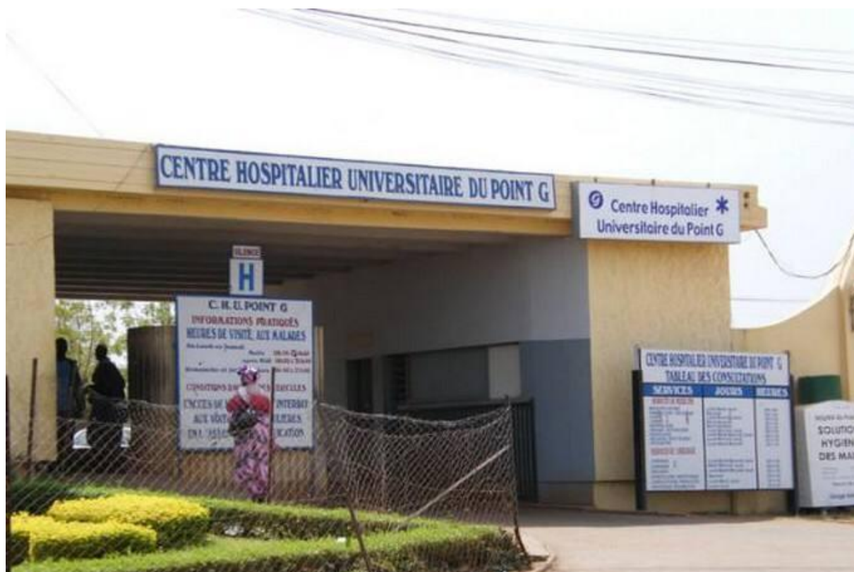
Figure 8: Face de l'entrée principale du CHU Point G.
