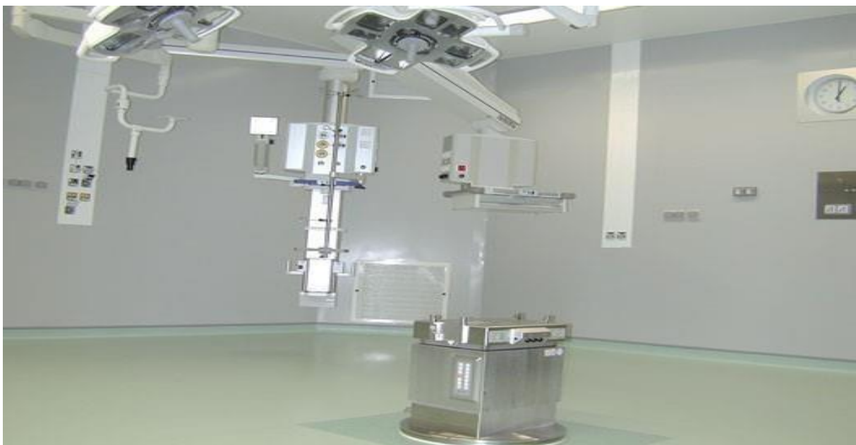
Figure 3 : bloc opératoire vide
