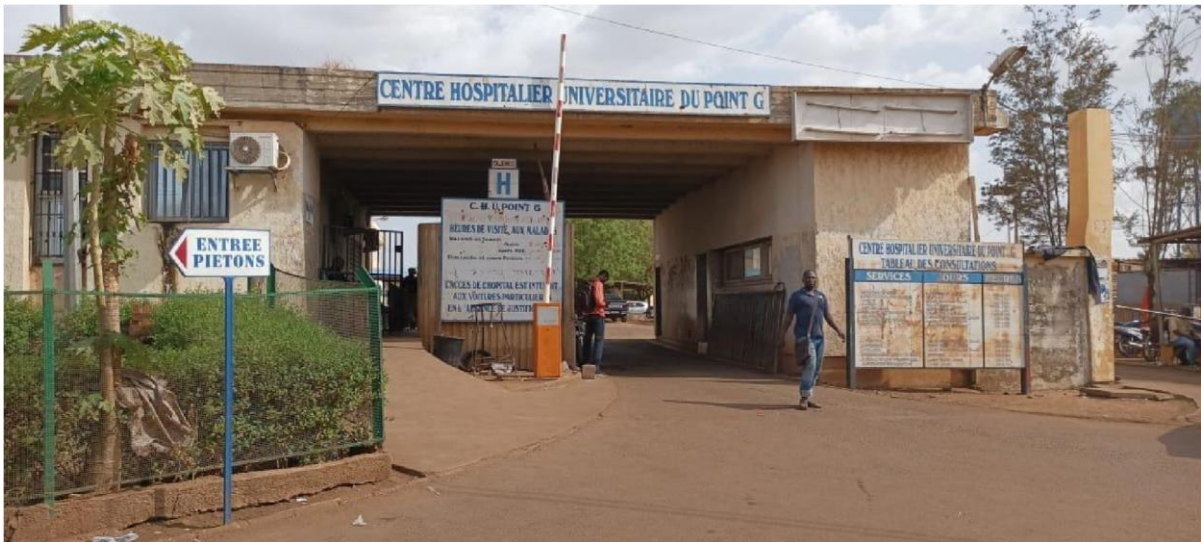
Figure 24 : Entrée du CHU Point G.
