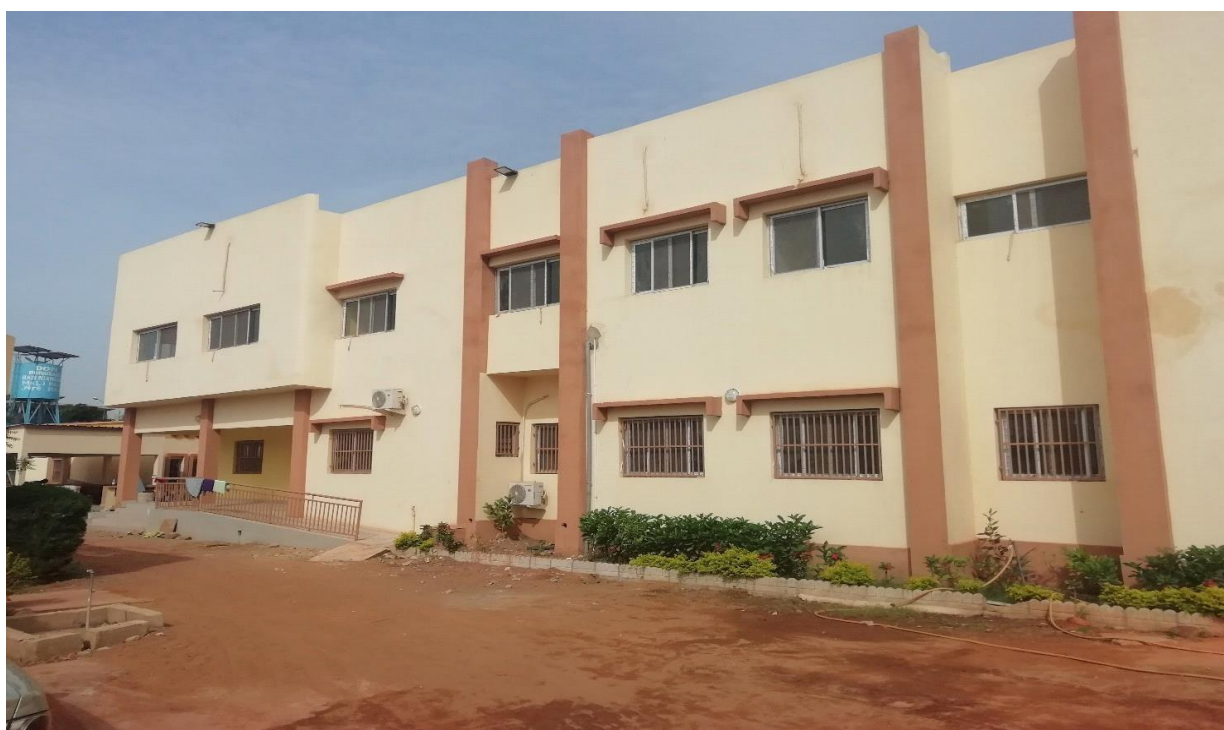
Figure 5 : Vue photographique de la façade principale du service de pédiatrie
