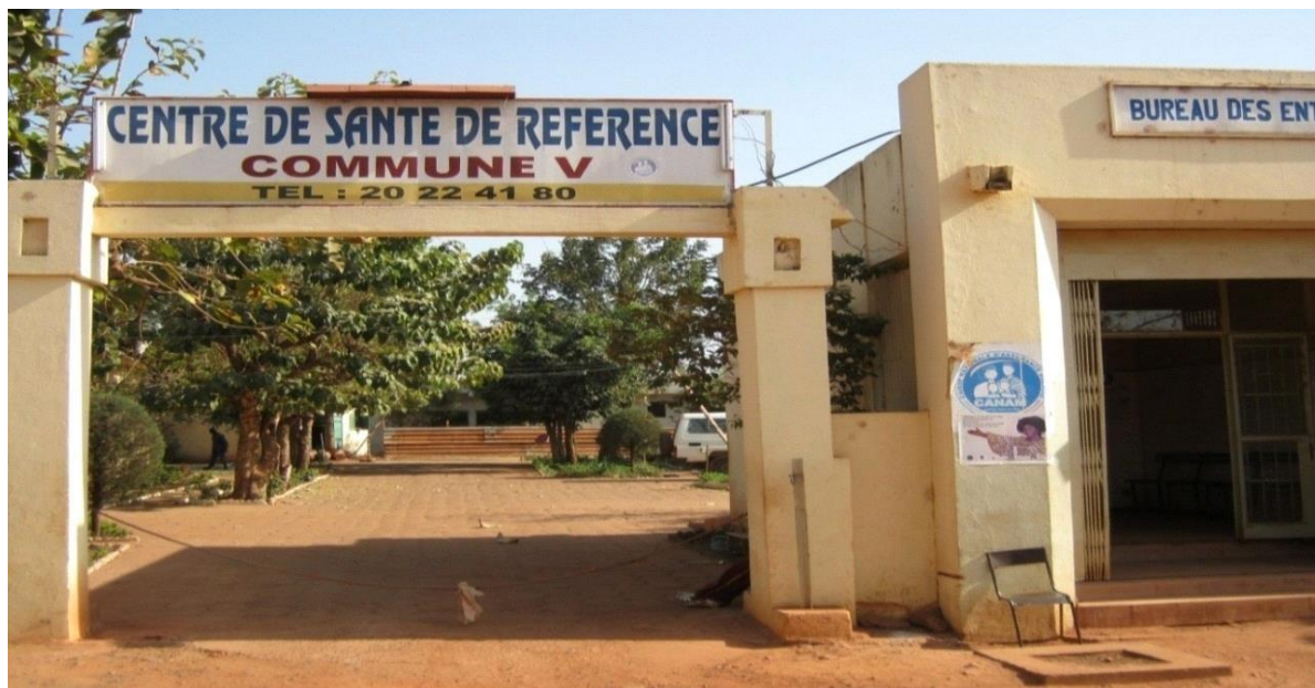
Figure 3 : Vue photographique de la façade principale du centre de santé de référence de la commune V du district de Bamako
