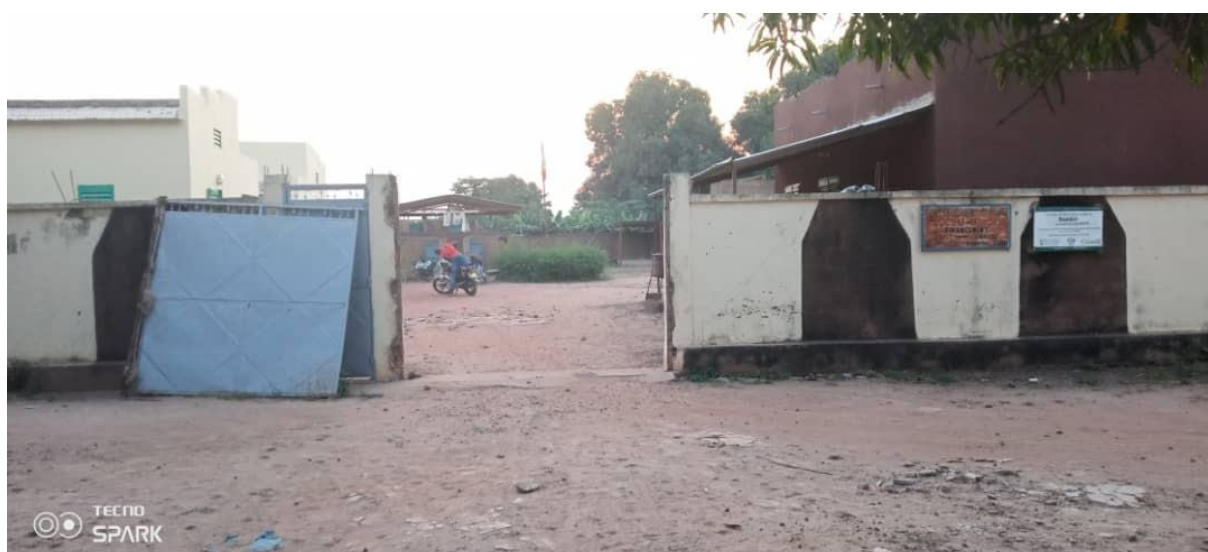
Figure 10 : CSCOM de Mambiri (Kita).
