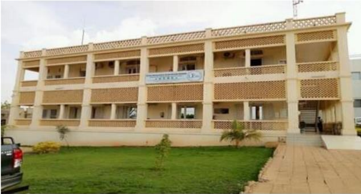
Figure 8 : photo du bâtiment de l'UCRC.
