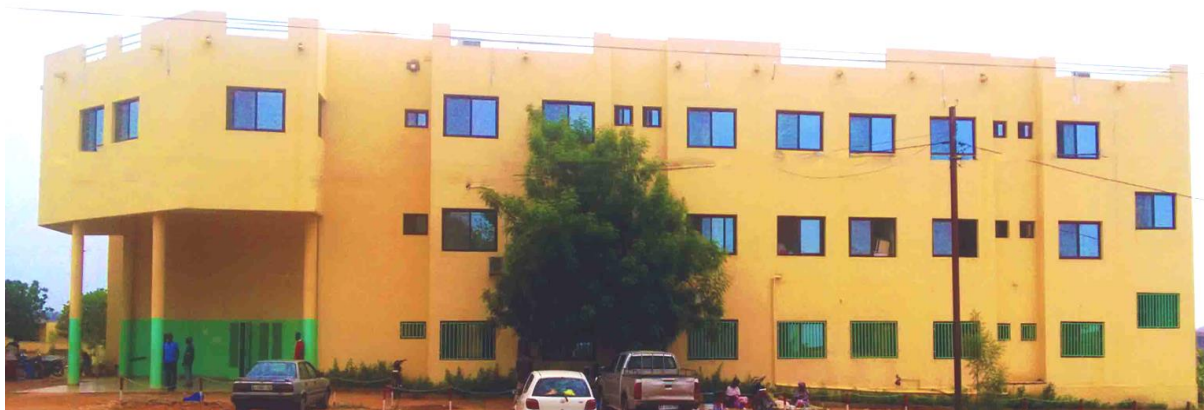
Photo 2 : Vue d'ensemble de face convexe – Médecine Interne côté sud au bord de la route
