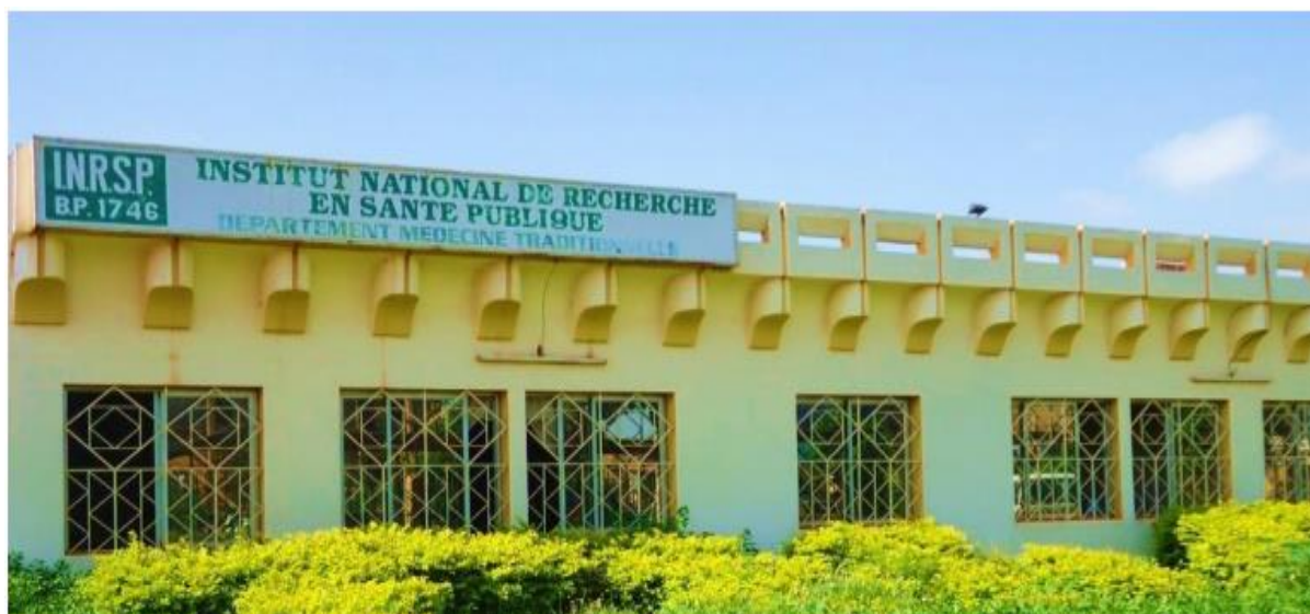
Figure 10: Photo d'une façade du Département de Médecine Traditionnelle.
